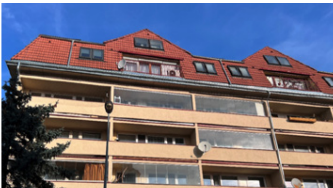
Pohled na posuzovanou střechu
