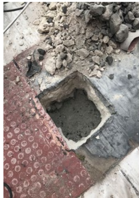
Sonda do skladby původní střechy
