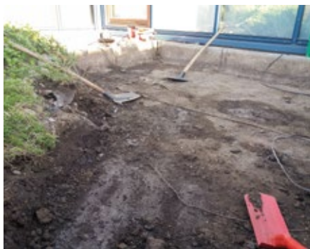
6) Ornice na střeše nepatří. Je nepropustná, příliš organická, zanáší drenážní cesty a může přetížit střechu.
