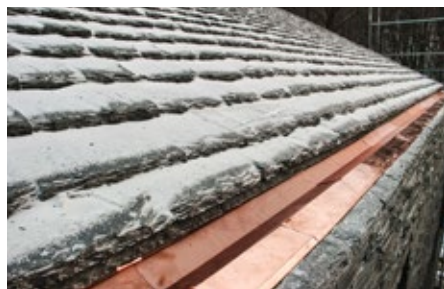
Hotová střecha se zaatikovým žlabem
