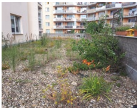
8) Kačírková střecha, která nebyla udržována tak dlouho, až se z ní stala střecha zelená
