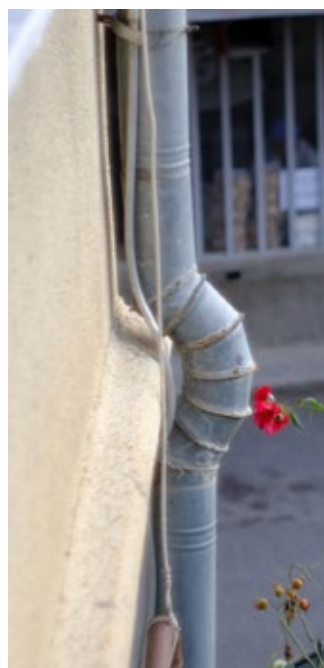
Svod kopírující fasádu
