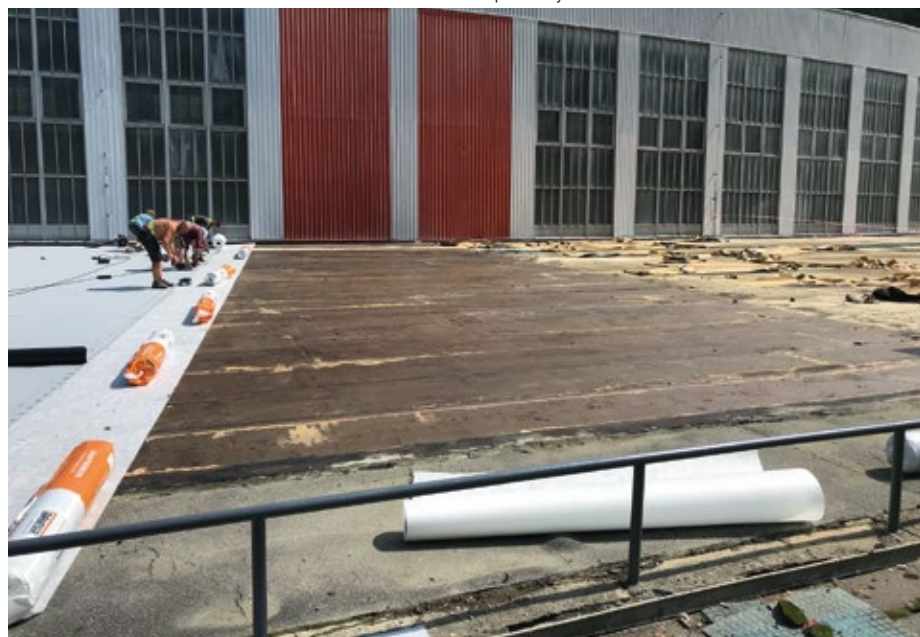
Pokládka nové folie
