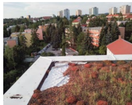
7) Absence kačírkových pásů podél atiky je velkým rizikem z hlediska větrné eroze.
