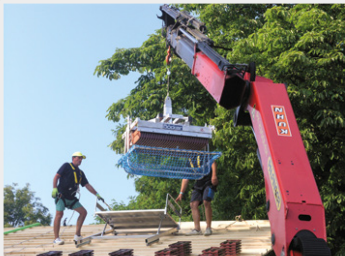
Ukázka transportu s použitím speciálních kleští a pojízdné rampy Böcker
