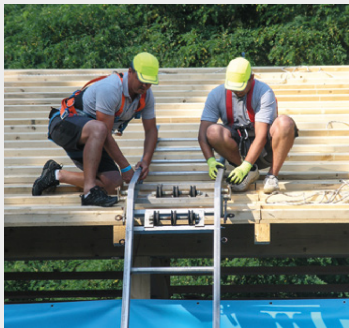
Družstvo klasiků - montáž výtahu Geda
