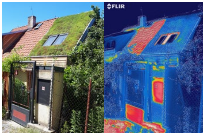
Vítězná vegetační střecha roku 2019 (foto Isover) a její termovizní snímek
