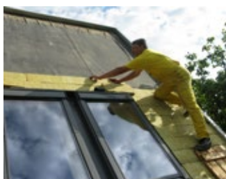
Pokládka hydrofilní minerální vlny Isover na hydroizolaci EPDM (foto Acre)
