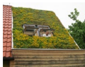
Vegetační střecha po třech letech od realizace (foto Acre)
