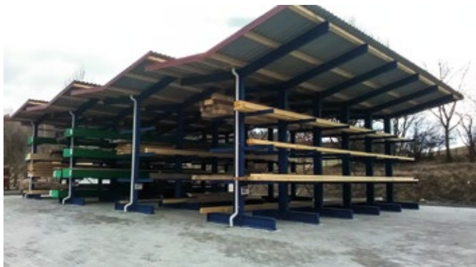
Zastřešený regálový systém má dostatečnou kapacitu na skladování
