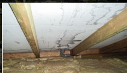
VĚTRÁNÍ STŘECH V PRAXI ANEB ČEMU VĚNOVAT POZORNOST, str. 6
