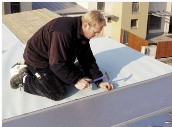
Obr. č. 3 Správně prováděná pokládka plechu Prefalz na pultové střechě domů stavených pro firmu Singa v Zelenči u Prahy. (klempíř pan M. Houska)
