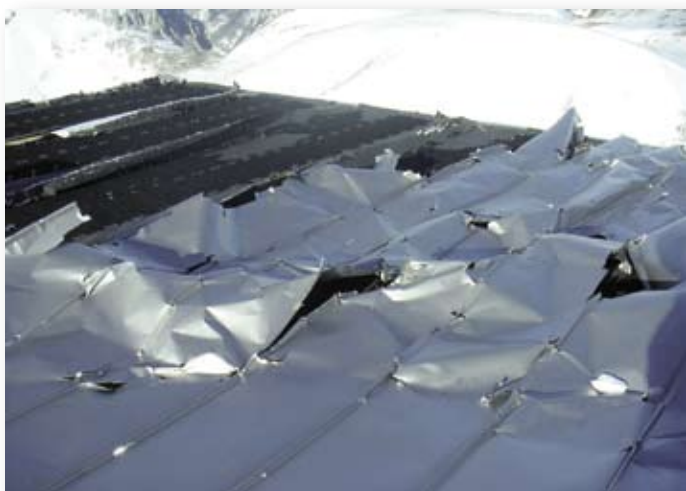
Obr. č. 2 Alpy, pásy nerezové oceli, zavírání drážek nikoliv postupně, ale najednou.
